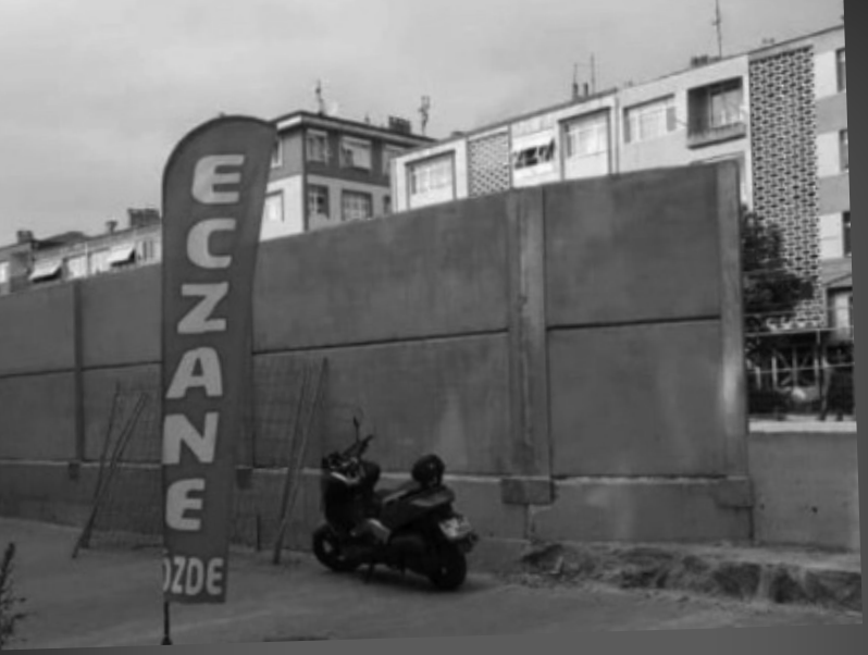
Bakırköy'deki tren yolu duvarları
